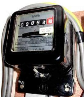
Se il **fattore di potenza** misurato ( $\cos \Phi$ ) risulta inferiore a 0,9, il fornitore applica un onere economico aggiuntivo, indicato in bolletta alla voce "energia reattiva". Portare il fattore di potenza medio di funzionamento della rete da 0,7 a 0,9 significa:
